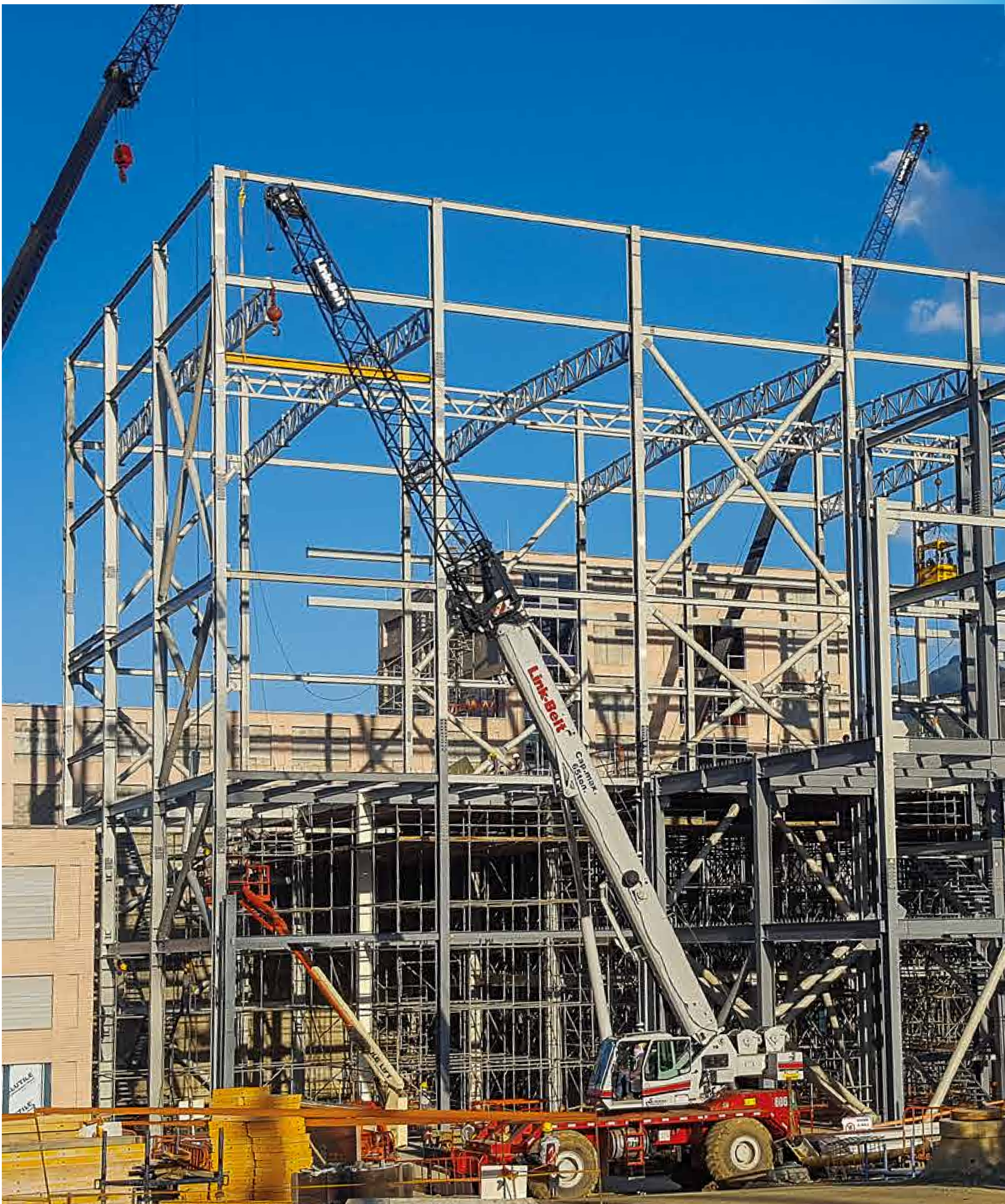
Edificio Planta de Aguas Claras Medellín, Antioquia – 740 toneladas
